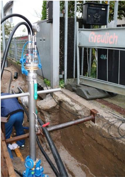
**Bild 4:** Kontraktions-Druckprüfung: Messaufbau mit Prüfstandrohr und Prüfkörper L
